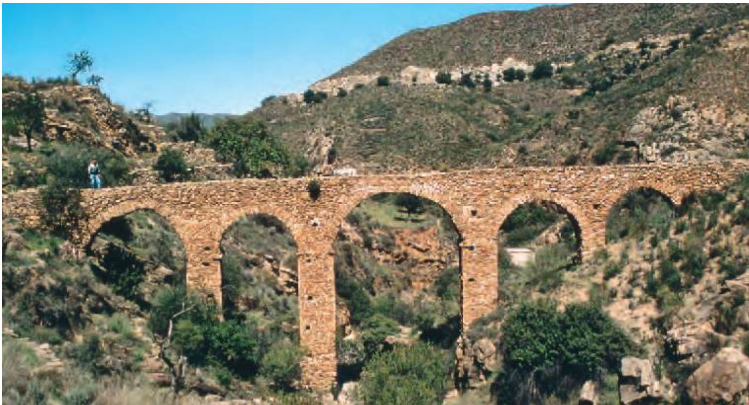
6.4 Acueducto de Albanchez. Otro acueducto de cronología dudosa, aunque probablemente romano 39 (3 de abril de 1999)
