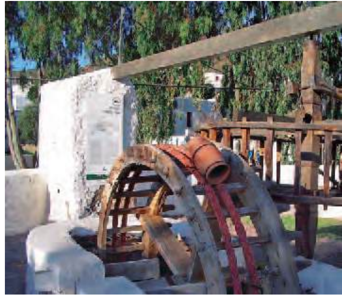
7.2 Noria en el Pozo de Los Frailes, Cabo de Gata. La noria forma parte del conjunto de tecnologías hidráulicas introducidas por los árabes en España, gracias a ella era posible acceder a acuíferos situados a poca profundidad (29 de diciembre de 2004).
