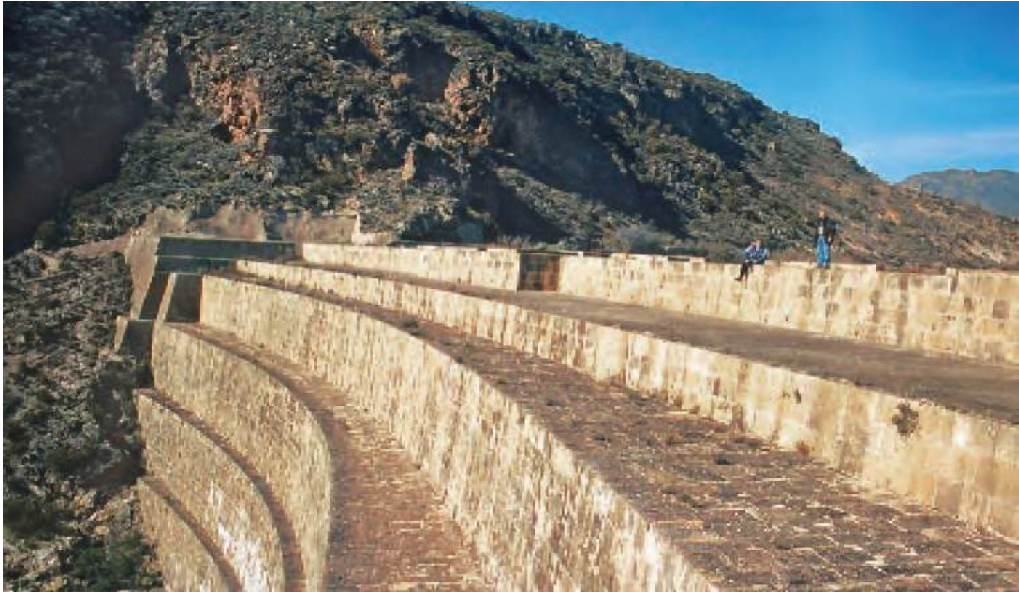
9.45 Presa, de casi 40 metros de altura, del pantano de Isabel II, en la ladera sur de sierra Alhamilla. El pantano fue construido a mediados del siglo XIX con capital privado para poner en riego el Campo de Níjar. Resultó un absoluto fracaso. Las altas tasas de erosión de la cuenca que debía alimentarlo lo colmataron de sedimentos en pocos años
