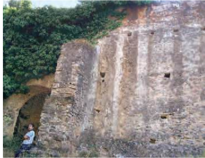
9.31 Ruinas de la fundición de hierro construida a principios del siglo XVIII por el duque del Parque en Córdar. Las antiguas fundiciones sólo podían establecerse en zonas que, además del mineral adecuado, contaran con energía hidráulica para mover los martinets y grandes cantidades de biomasa vegetal para fundir los minerales. Las fundiciones almerienses de hierro de los siglos XVI al XIX se encontraban en la parte occidental de la sierra de Filabres y en La Alpujarra. Nuestro amigo Francisco Martínez Botella se prestó amablemente, una vez más, a servir de “escala” en la fotografía
